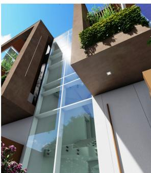
nella forma e partitura come da elaborati di progetto, sistema montanti e traversi in alluminio e pannelli vetro camera (semi strutturale) secondo le disposizioni del termotecnico. Un pannello/vetro, nella parte alta della vetrata, sarà dotato di apertura al fine di arieggiare il vanoscala. La porta di accesso al vano scala sarà realizzata anch'essa con struttura in alluminio e tamponamento con vetro camera colore opalino o bianco oltre a maniglione verticale e serratura con incontro elettrico..
