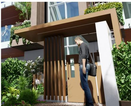
Elemento di ingresso su via Fattoti sarà realizzato con struttura in cls intonacato per quanto riguarda il fianco di sostegno alla pensilina e la parete bassa, mentre la pensilina sarà realizzata con struttura in ferro e rivestita in pannelli di Unipan. Le lame metalliche che “sfondano” in altezza la pensilina saranno realizzate con profili in alluminio della sezione di circa cm.5x20 e finitura bronzo o similare.
