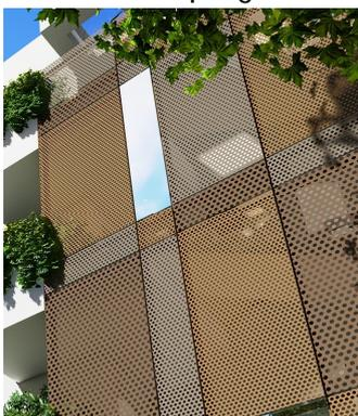
diverse dimensioni, piegata a formare singoli pannelli staccati tra loro di cm.2 circa che saranno fissati alla sottostruttura sottostante in ferro di adeguata sezione e dimensione, zincato a caldo e verniciato, a sua volta fissato alle solette della scala condominiale. Tutta la pannellatura metallica della scala sarà verniciata a smalto a tre colori a scelta D.L.
