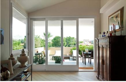
Infissi esterni in legno laccato, con vetro camera con garanzia di abbattimento acustico di almeno 40 db e coef. Termico di almeno 1,1, in ogni caso atto a garantire gli standard termici di progettazione in classe “B”
